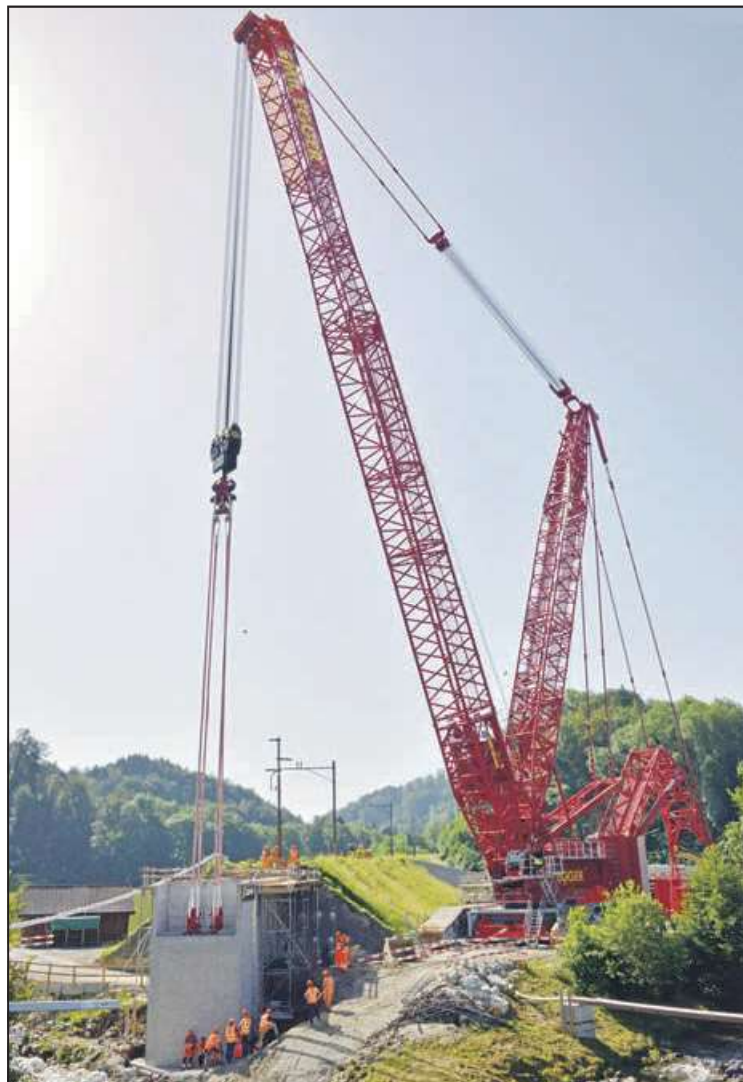
Pose de la culée côté Fribourg sous les yeux de ingénieurs venus d'Allemagne
