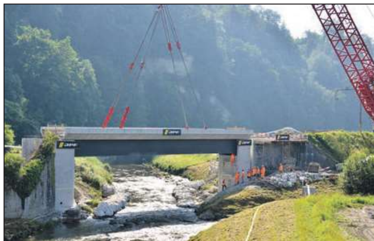
Le nouveau pont est mis en place
