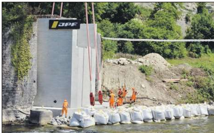
Pose de la culée côté Moudon
