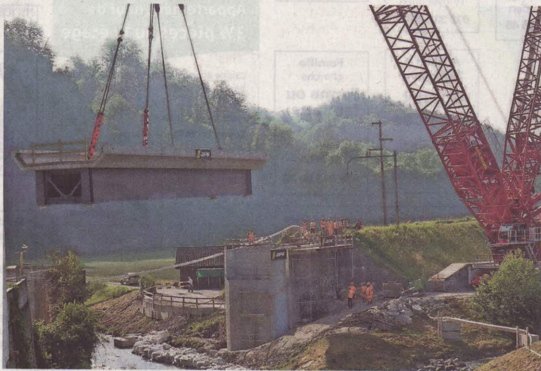
La grue, qui nécessite 34 camions pour son transport, a soulevé avec facilité le pont de 350 tonnes.
