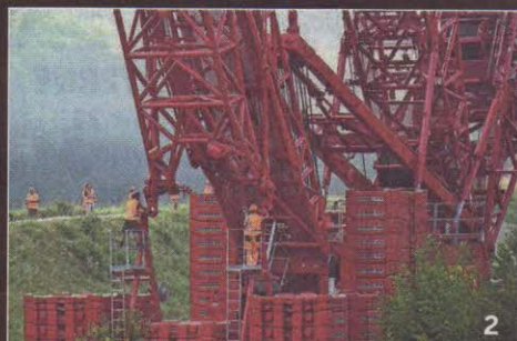
La grue, qui nécessite 34 camions pour son transport, a soulevé avec facilité le pont de 350 tonnes.
