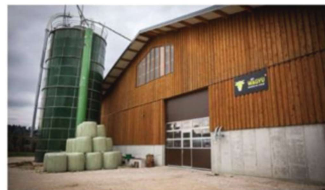
Des installations neuves, adaptées au bien-être des animaux.
