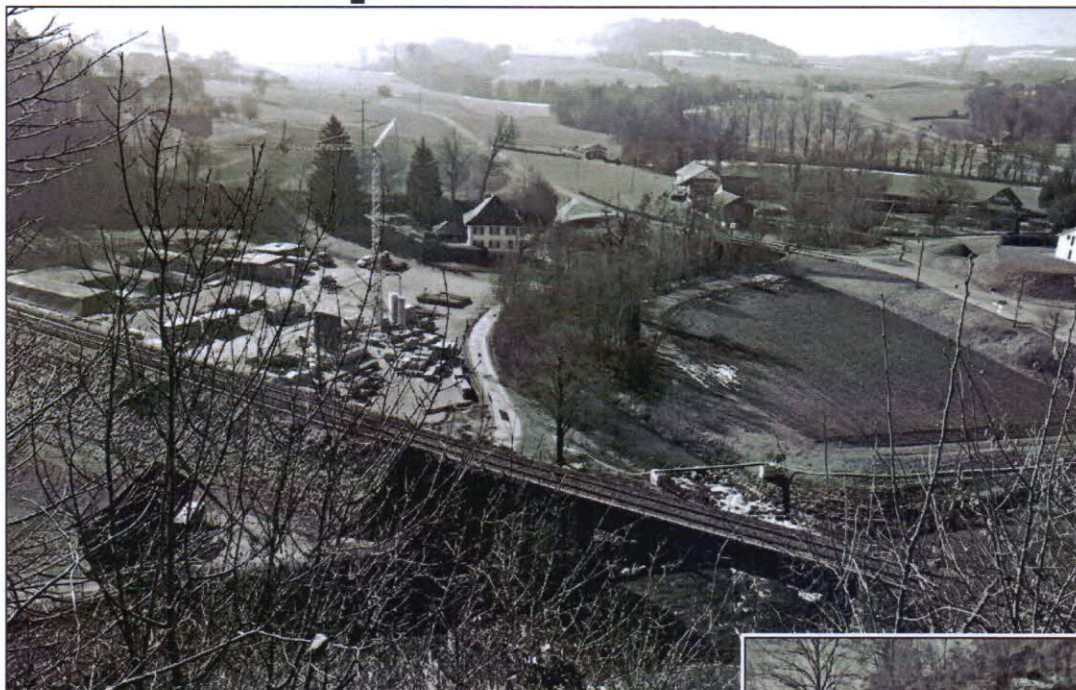
Vue d'ensemble du pont CFF et du chantier de préparation
