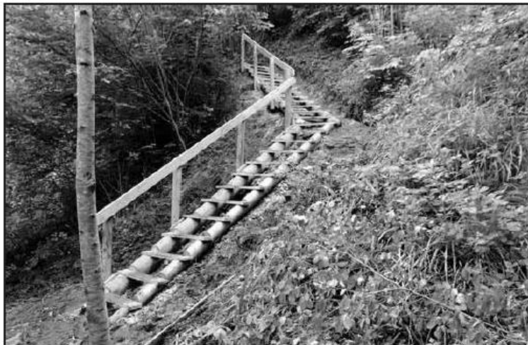
L'escalier récemment construit à Vulliens
