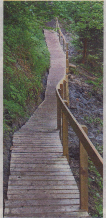
Une rampe toute neuve, à l'assaut de la colline.
